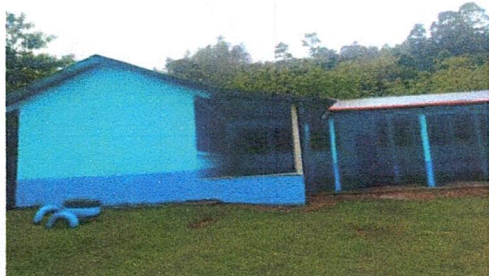
Foto1: Vista panoramica estado actual despues de la pintada del edificio, las ventanas y puertas.
