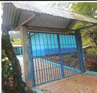
Foto 3: Puerta principal colocada.
