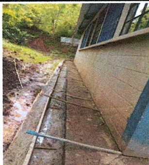
Foto 5: Canal de concreto colocado.
